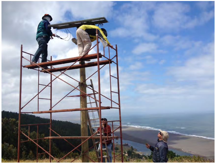
La instalación del sistema se realizó con ayuda de alumnos de Ingeniería Hidráulica y Eléctrica de la Escuela de Ingeniería UC, además del Departamento de Obras Civiles de la Universidad Santa María.
