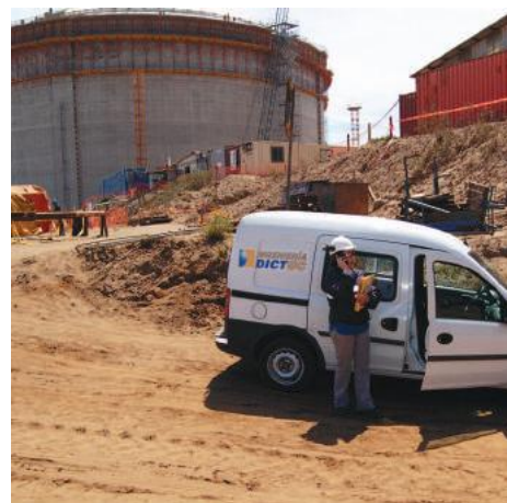
DICTUC realizó la certificación de estanques e instalaciones eléctricas para la planta GNL Quintero.
